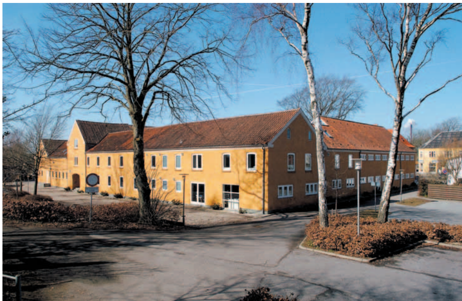
»Jydens« gamle fabriksbygninger er i dag renoveret og benyttes bl.a. til bibliotek og lokalhistorisk arkiv. Peder Andersens gamle direktørbolig, tegnet af Søren Vig-Nielsen, er indrettet til cykelmuseum. Foto: Kurt Nielsen.
